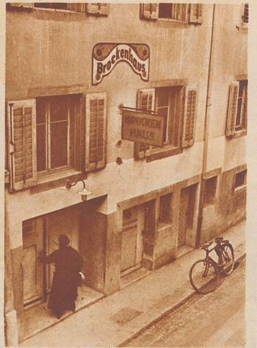
Eingang zum Brockenhaus an der Grabenstraße in Luzern. Oft umgebaut und abgeändert, ist diese Front heute nicht mehr als ehemalige Kapellenfassade erkennbar.
