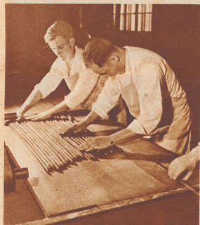
Jeder dieser langen, dünnen Stäbe aus weicher Zuckermasse — 24 sind es — gibt erst einen weissen runden Tupf der Erdbeere. Dann werden die Stäbe zu einem Bündel zusammengelegt, die bilden dann die Erdbeere. Darauf wird noch eine grüne Zuckermasse gelegt, für den Kelch und den Stiel der Frucht.
