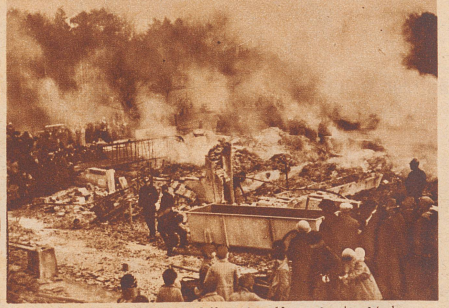
15 Stück Vieh, 900 Kubikmeter Heu. In der Nacht vom letzten Samstag zum Sonntag brannte das Oekonomiegebäude des «Bruderholzhofes» in Oberwil bei Basel bis auf den Grund nieder. 15 Stück Großvieh, alle Futtermittel und zahlreiche landwirtschaftliche Maschinen verbrannten. Der Schaden beträgt 100 000 Franken. Aufnahme Diriwächter
