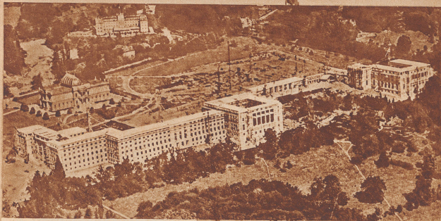
Flugbild des Völkerbundspalastes im Genfer Arianapark am Tage des Aufrichtfestes am 5. November 1933. Nach 2½-jähriger Bauzeit ist der riesige Rohbau fertiggeworden. Das ganze setzt sich aus fünf Teilen zusammen: In dem quadratischen Teil der Mitte ist der Versammlungs-saal placiert, rechts und links schließen sich die Flügel für die Kommissionen an, dann folgt der Teil für Völkerbundsrat und Bibliothek von ebenfalls quadratischer Grundform. Das Sekretariat umfaßt gegen 400 Bureaux.
