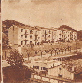
Eine Reihe Arbeiterhäuser, die die Firma bauen ließ. Die Häuser sind der Gegend angepaßt, die Wohnungen hygienisch einwandfrei. Die Miete beträgt für eine Vierzimmerwohnung 3,50 Pesetas pro Woche. Die Farga zählt 630 Einwohner. Etwas Zweidrittel der Arbeiter wohnen in den Häusern der Firma.
