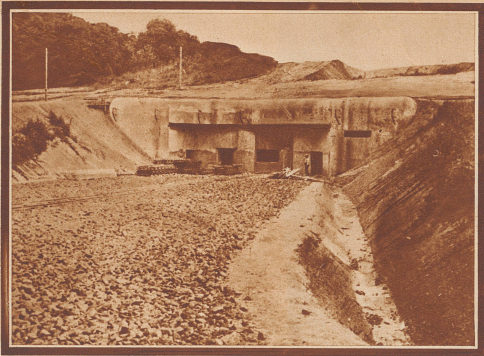
Eingang zu den unterirdischen Befestigungen. Solche Eingänge sind gegen Sicht, gegen Gas und gegen Bomben besonders geschützt, von ihnen aus verzweigen sich die Gänge zu den Kasematzen. Die Mannschaften, die in naheliegenden Kasernen untergebracht sind, lassen sich im Ernstfall dank des gelegenen Schienennetzes innert kürzester Frist auf sämtliche unterirdische Stellungen verteilen.
