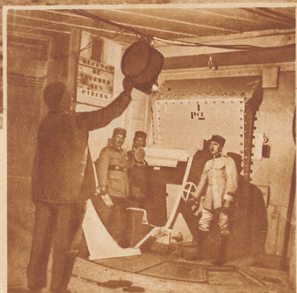
Blick ins Innere einer Kasematte. Der Geschützraum, bestückt mit Geschützen neuester Konstruktion. Periskope, wie sie von Unterseebooten gebraucht werden, gestatten die Kontrolle des Geländes und die genaue Einstellung der Geschütze.
