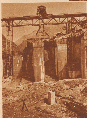
Das Dixence-Werk im Wallis. Im Vordergrund ein Ausschnitt aus der entstehenden Riesenstaumauer, darüber die verschiebbare Baubrücke. Hinter der Staumauer, von der Dixence durchflossen, die unfruchtbare, öde Talsohle. Hier wird sich nach der Stauung ein See von 500 Meter bis 800 Meter Breite, 4 Kilometer Länge und einem Fassungsvermögen von 50 Millionen Kubikmeter ausdehnen
