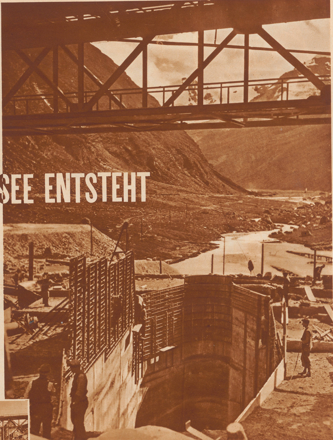
Das Dixence-Werk im Wallis. Im Vordergrund ein Ausschnitt aus der entstehenden Riesenstaumauer, darüber die verschiebbare Baubrücke. Hinter der Staumauer, von der Dixence durchflossen, die unfruchtbare, öde Talsohle. Hier wird sich nach der Stauung ein See von 500 Meter bis 800 Meter Breite, 4 Kilometer Länge und einem Fassungsvermögen von 50 Millionen Kubikmeter ausdehnen
