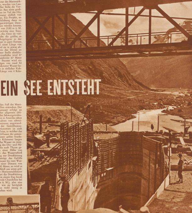
Das Dixence-Werk im Wallis. Im Vordergrund ein Ausschnitt aus der entstehenden Riesenstaumauer, darüber die verschiebbare Baubrücke. Hinter der Staumauer, von der Dixence durchflossen, die unfruchtbare, öde Talsohle. Hier wird sich nach der Stauung ein See von 500 Meter bis 800 Meter Breite, 4 Kilometer Länge und einem Passungsvermögen von 50 Millionen Kubikmeter ausdehnen
