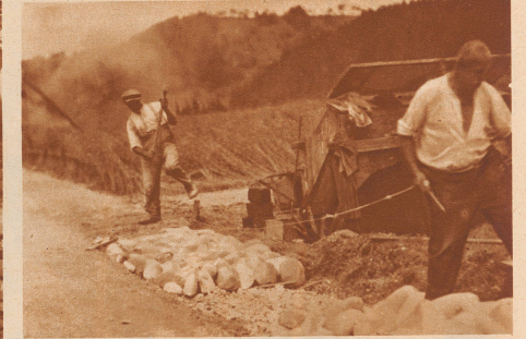
Auf der Landstraße gegen Willisau herrscht reger Betrieb. Dampfwalzen knirschen und rumpeln über harte Steine. Arbeiter pickeln und hämmern, der holprigen Straße ein neues Steinbett schaffend. Der Wandler steht still und läßt sich von einem Straßenarbeiter über den dauerhaftesten Straßenbelag unterrichten, den es gibt.
