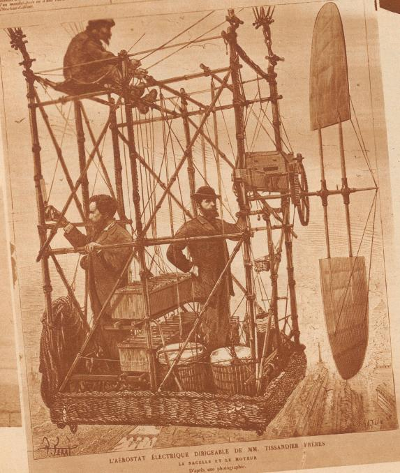
Links: Die Gondel mit dem Motor des elektrisch angetriebenen, lenkbaren Ballons der Brüder Tissandier bei einem Fluge über Paris im Jahre 1883. Zeitgenössische Publikation in der Pariser „Illustration“.
