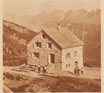
Skihütte «Gaffia» am Piz Sol. Dieses neueste Unterkunftshaus im idealen Skigebiet des Piz Sol steht auf 1780 Meter Höhe. Es ist ein massiver Natursteinbau, der sich ausgezeichnet der Umgebung anpaßt. Die Baukosten belaufen sich auf rund 50 000 Franken. Die Hütte ist in 3¼ Stunden von Wangs aus erreichbar. Aufnahme Fetzer
