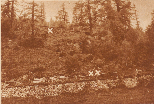
× Die Absturzstelle an der Kurve der Julierstraße. ×× Der Platz des abgestürzten Wagens an der tiefer gelegenen Strecke der Julierstraße Aufnahmen Siegle
