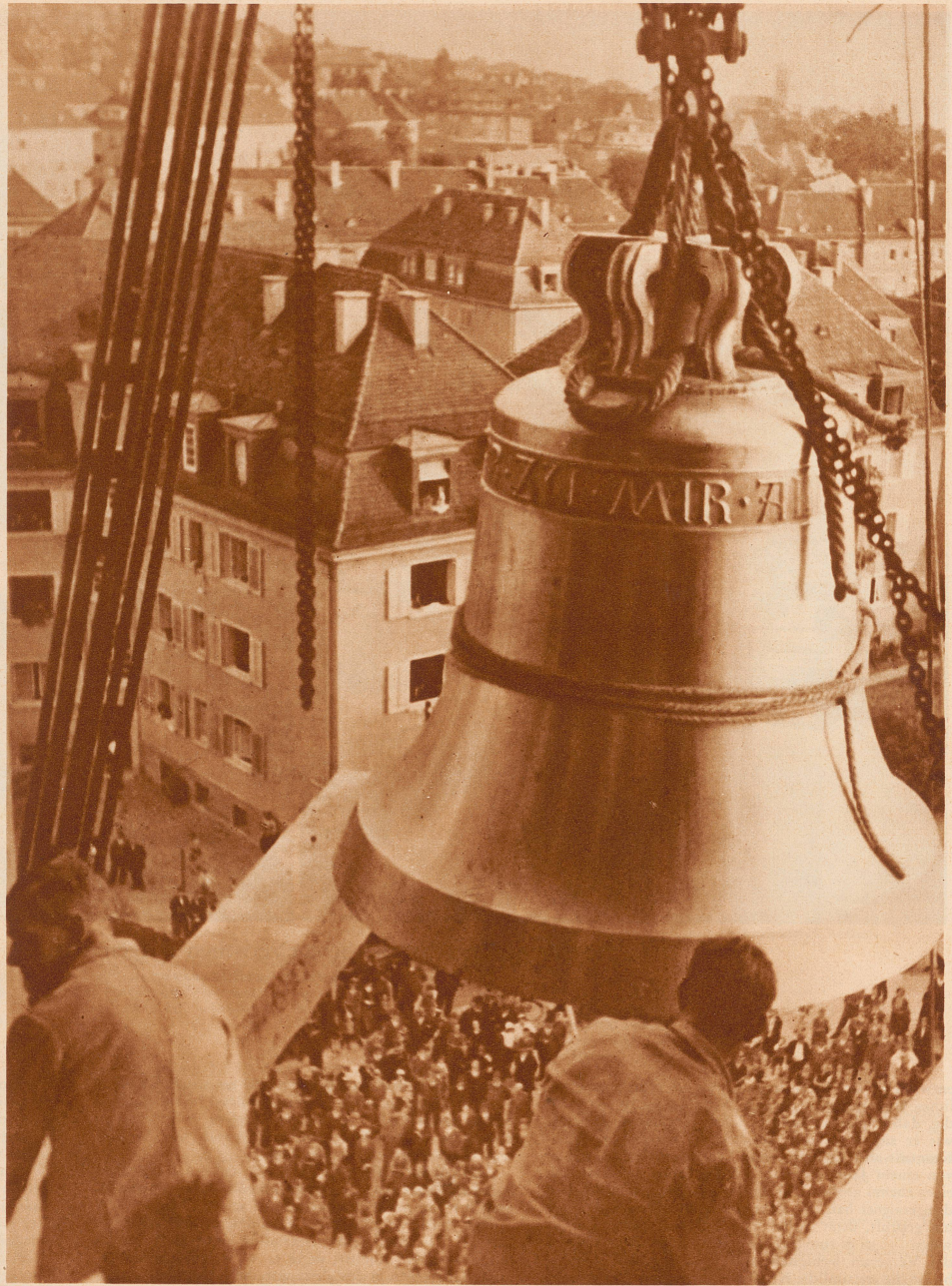
Oben angekommen, werden die Glocken auf Balken und Rollen ins Innere des Glockenstuhls geschafft
