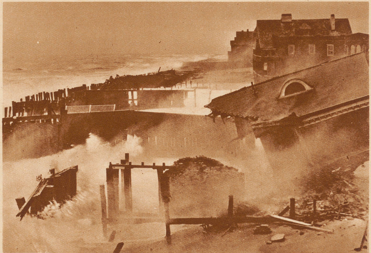
Sturm über der Ostküste von U. S. A. Die östlichen Staaten der Union sind von einer schweren Unwetterkatastrophe heimgesucht worden. Zahlreiche Gebäude, Deiche, Straßen und Telefonleitungen sind von Grund auf zerstört. - Unser Bild zeigt die von der Sturmflut arg mitgenommenen Quaianlagen und eingestürzte Häuser im Badcourt von Long Branch
