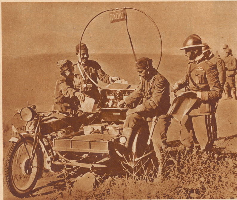
Radiowagen des italienischen Feldheeres. Zum erstenmal wurden in den eben zu Ende gegangenen großen Manövern der italienischen Armee in Piemont Motorräder mit Radiobeiwagen verwendet
