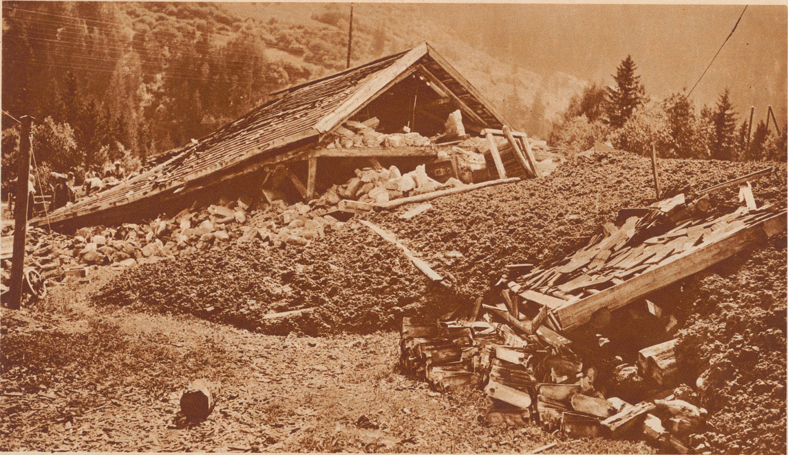
Schwerer Riefengang im Unterengadin. Bei Strada ist am Freitag die große Rufe aus Val Ruinaiis niedergelassen. Sie zerstörte drei Brücken und eine neuerbaute Mühle. Mit knapper Not konnten sich die Bewohner aus dem einstürzenden Hause retten Aufnahme Feuerstein
