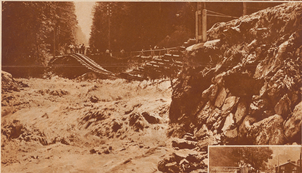
Eine Eisenbahnlinie hängt in der Luft. In der kurzen Zeit von einer Stunde hatten die Fluten der Weißen Lüttschne den Bahndamm der B. O. B. zwischen Lauterbrunnen und Zweilütschlenen radikal weggeschwemmt. Auf einer Strecke von 50 Meter hängen Schienen und Schwellen in der Luft wie eine Lianenbrücke im tropischen Urwald.
