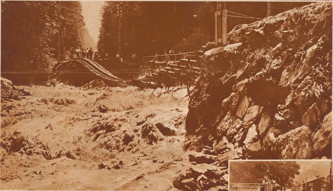
Eine Eisenbahnlinie hängt in der Luft. In der kurzen Zeit von einer Stunde hatten die Fluten der Weißen Lüttschine den Bahndamm der B. O. B. zwischen Lauterbrunnen und Zweilüttschinen radikal weggeschwemmt. Auf einer Strecke von 50 Meter hängen Schienen und Schwellen in der Luft wie eine Lianenbrücke im tropischen Urwald
