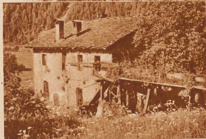
Fast jedes Dörfchen im Tal von Bagnes hat seine eigene Mühle, wo nach uralter Methode mittelst eines oberflächlichen Wasserrades jeder Dorfbewohner sein kleines Quantum Korn selber mahlt
