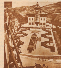
Die frühere Schule von Predappio, in der Mussolinis Mutter unterrichtet ist jetzt «Casa comunale» und mit großem Aufwand renoviert worden. Im ersten Stock sind «Erinnerungsräume»: Fußböden aus Marmor, kostbare Möbel, geschnitzte Ebenholzintarsien. Die Blumen des Gartens haben einzig der faschistischen Symbolik zu dienen
