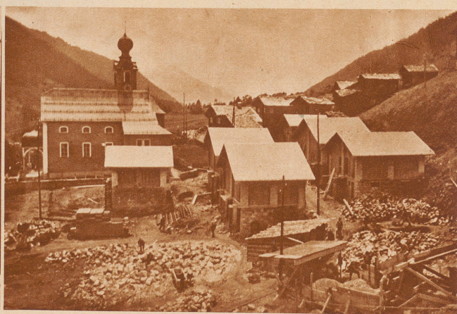
15. Juni 1933 Neun Monate später. Mit freundeidgenössischer Hilfe und anerkannter Mitarbeit der Schweizerischen Studentenschaft ist der Wiederaufbau von Blitzingen so weit gediehen, daß die neuen Häuser und Scheunen in kurzer Zeit bezogen werden können
