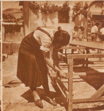
. . . . und alle, auch die Studentinnen, arbeiten eifrig mit beim Aufbau des Theaters. In einer Viertelstunde schon steht die Bühne fertig da, und die Vorstellung kann beginnen
