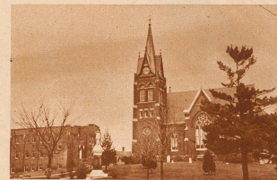
Das zirka 1000 Einwohner zählende Städtchen hat zwei Kirchen, die große schweiz. reformierte und eine kleine Holzkapelle für die evangelische Gemeinde. Unser Bild zeigt die erstere. Sie wurde im Jahre 1900 auf einer kleinen Anhöhe erbaut, auf der einst die erste Siedlerhütte stand. Vor der Kirche steht das Denkmal zu Ehren der ersten Glarner Auswanderer, ringsherum noch einige wenige Grabsteine der ersten Siedler, links das Zwinglihaus für die Sonntagsschule
