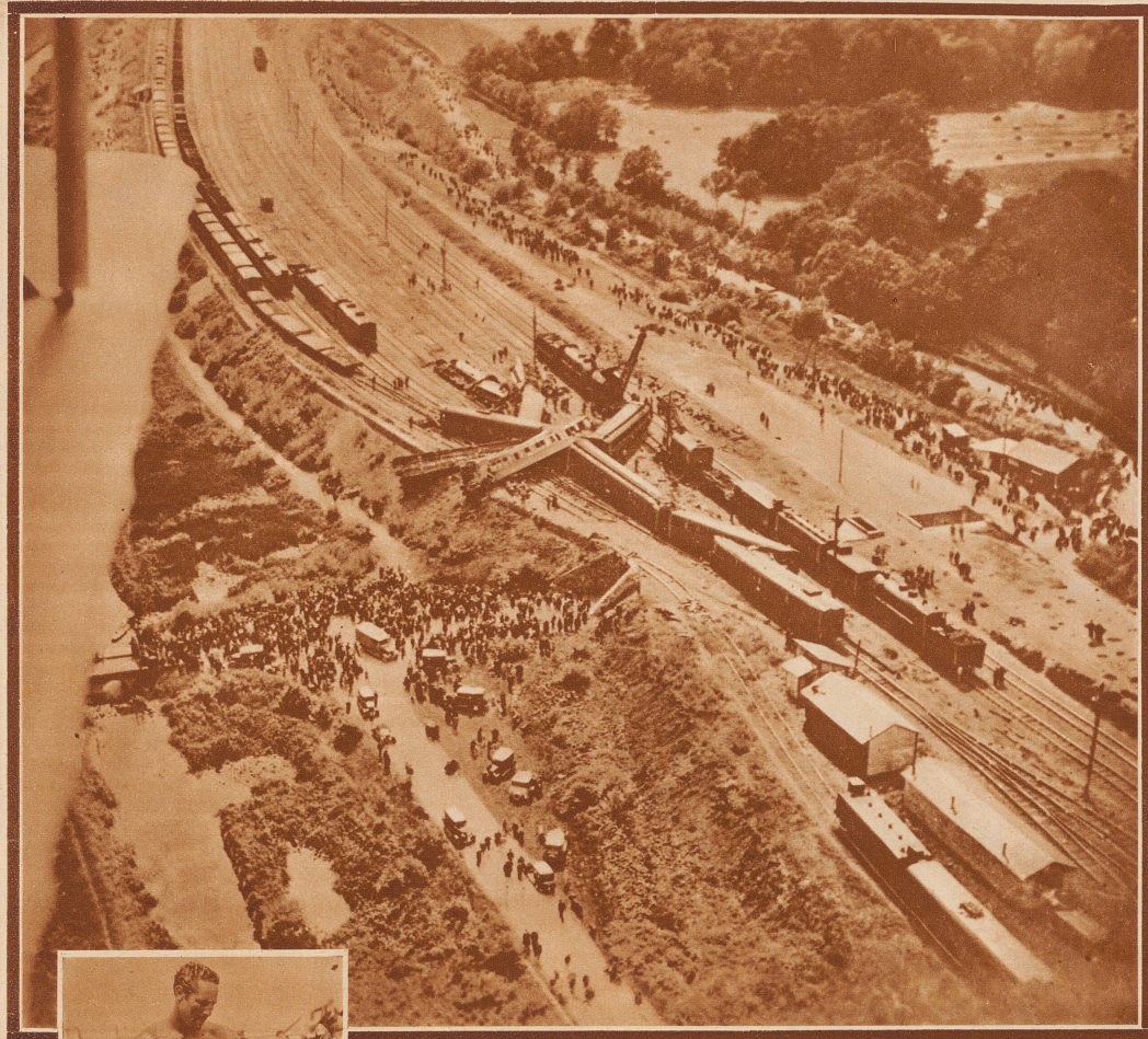
Schweres Eisenbahnunglück in Frankreich. Auf der Strecke Paris-Nantes bei der Station Blottereaux ereignete sich am Pfingstsonntag eine katastrophale Zugsentgleisung. Der verunglückte Schnellzug fuhr mit 100 km Geschwindigkeit. Infolge zu raschen Bremsens sprang die Lokomotive aus dem Geleise. Acht Personenwagen wurden ineinandergeschoben, stellten sich quer zum Geleise und stürzten zum Teil um. 15 Reisende wurden getötet, 123 mehr oder weniger schwer verletzt. – Flugaufnahme der Stationsanlage von Blottereaux mit dem verunglückten Zug, eine Stunde nach der Entgleisung
