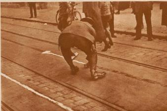
Für die Tabestandsaufnahme ist die deutliche Kennzeichnung der Brems- und Gleitspuren des verunglückten Autos wichtig. Der Zeichner der Alarmgruppe markiert die Bremsspuren mit Gips
