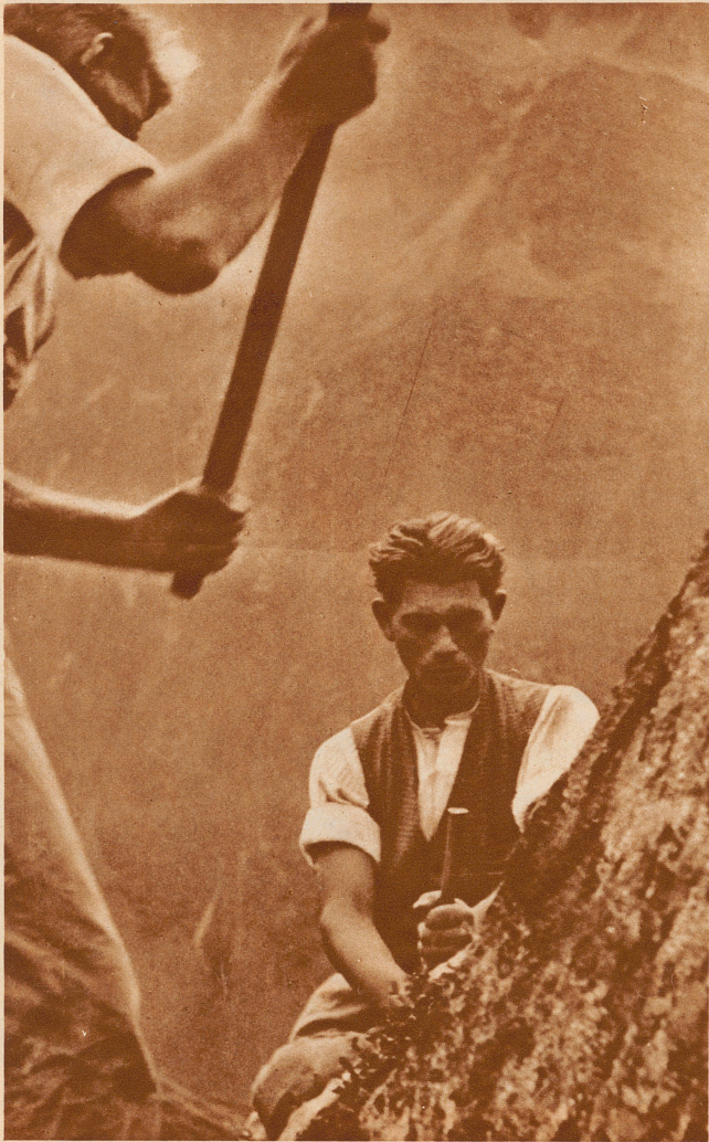
Links und rechts hoch oben am Berghang, möglichst auf vorspringender Felsennase, werden eiserne Träger im Urgestein eingebettet und so die Spanndrähte verankert
