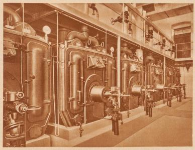
Eine Serie Zent-Kessel mit vollautomatischer Ölfeuerung
