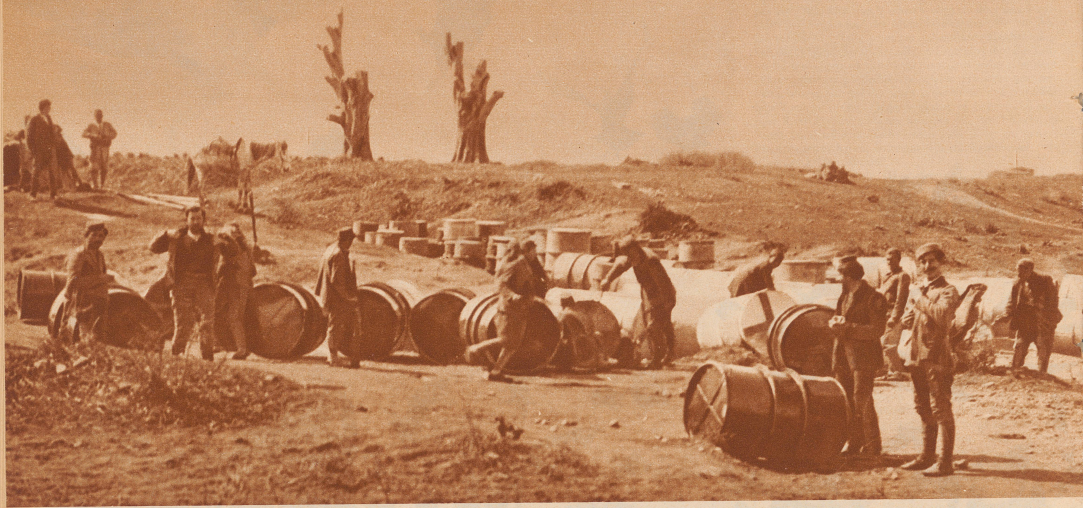
Montenegrinisches Sturmgerät im ersten Balkankrieg. Leere eiserne Benzinfässer wurden mit einem Holzgerüst ausgekleidet, das ringsum einen Spielraum von 10 cm übrig ließ, der dann ausbetoniert wurde. Bei der Belagerung von Skutari, im besondern beim Angriff der Stadt von der See-Ebene aus, wurden die Fässer von je drei Mann vor sich hergerollt und bildeten so einen ganz guten Kugelfang, der auch das heftigste feindliche Infanteriefeuer wirkungslos machte
