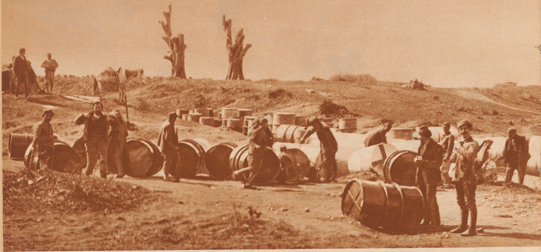
Montenegrinisches Sturmgerät im ersten Balkankrieg. Leere eiserne Benzinfässer wurden mit einem Holzgerüst ausgekleidet, das ringsum einen Spielraum von 10 cm übrig ließ, der dann ausbetoniert wurde. Bei der Belagerung von Skutari, im besondern beim Angriff der Stadt von der See-Ebene aus, wurden die Fässer von je drei Mann vor sich hergerollt und bildeten so einen ganz guten Kugelfang, der auch das heftigste feindliche Infanteriefeuere wirkungslos machte
