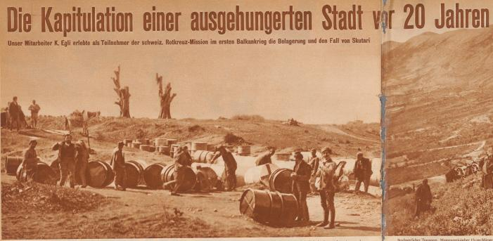
Montenegrinisches Sturmgerit im ersten Bilkankrieg. Leere eiserne Benzinfässer wurden mit einem Holzgerüst ausgekleidet, das ringsum einen Spielraum von 10 cm übrig ließ, der dann ausbetoniert wurde. Bei der Belagerung von Skutari, im besondern beim Angriff der Stadt von der See-Ebene aus, wurden die Fisser von je drei Mann vor sich hergerolt und bildeten so einen ganz guten Kugelfang, der auch das heftiggte feindliche Infanteriefeuer wirkungslos machte
