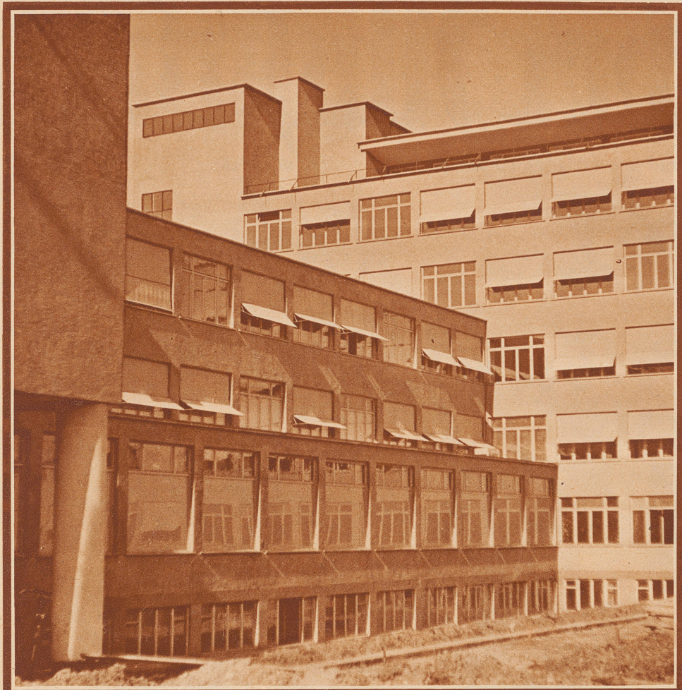
Das neue Gewerbeschulhaus in Zürich , dessen Eröffnung am 22. April feierlich stattfinden wird. Das Haus ist ein riesiger, von Architekt Egender entworfener Eisenbetonbau, der 6\frac{1}{2} Millionen Franken gekostet hat. Der Schultrakt mit über 50 Zimmer und 28 Werkstätten ist 102 Meter lang Aufnahme Staub
