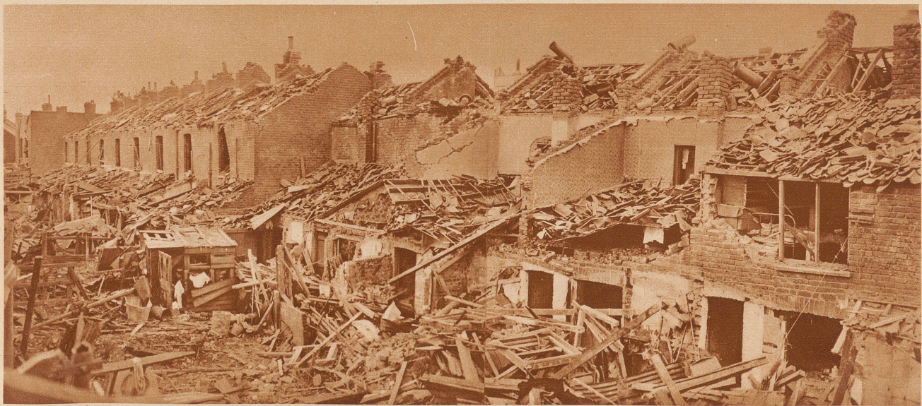
In Belgrave-Road, einem Industrieviertel von London, ereignete sich in einem chemischen Laboratorium aus bisher noch nicht geklärten Gründen eine Explosion von riesigen Ausmaßen und katastrophalen Folgen. Durch die Explosion wurden 12 Gebäude total zerstört. Ueber 30 Personen sind schwer und etwa 100 leicht verletzt, während merkwürdigerweise nur ein einziger Todesfall gemeldet wurde
