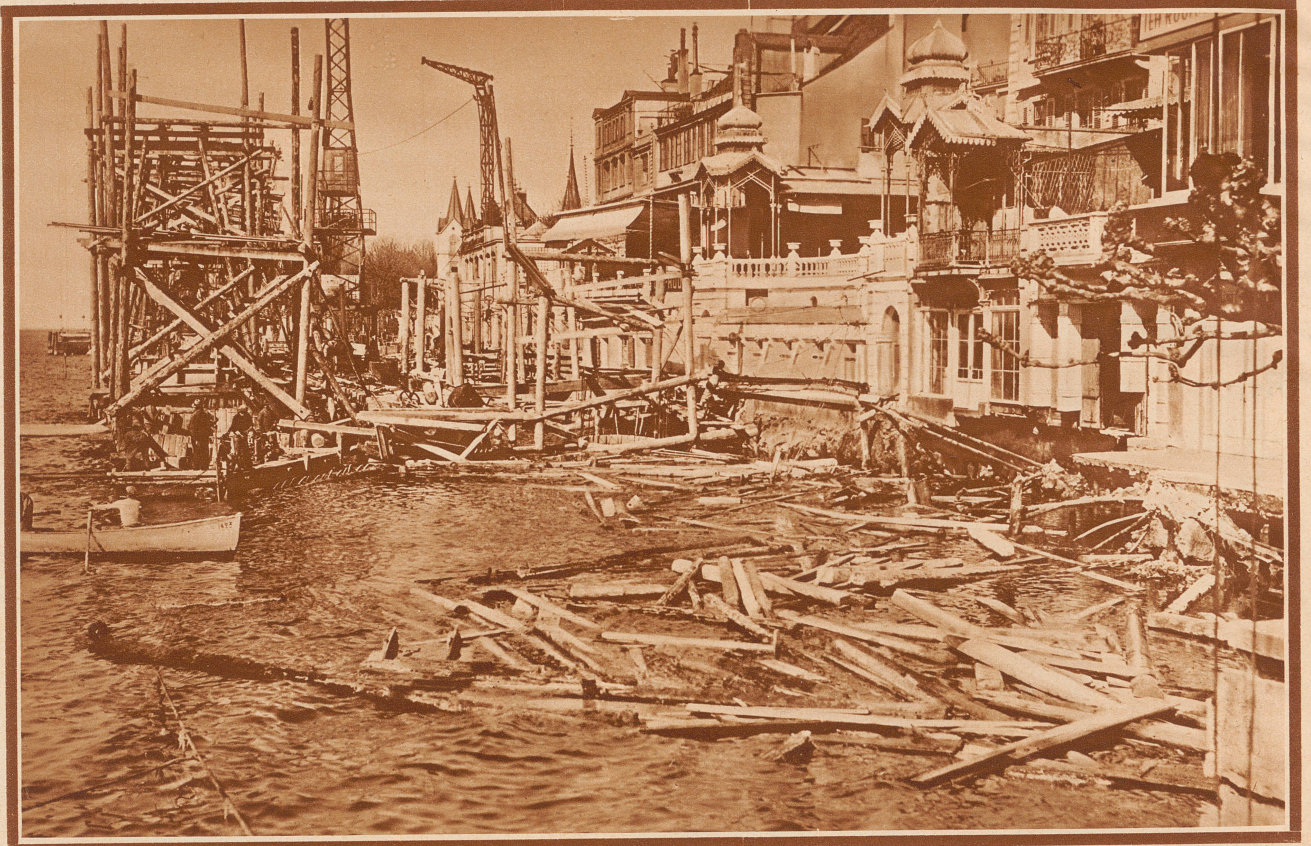
Quai-Einsturz am Genfersee. Seit mehreren Jahren sind in Vevey bedeutende Arbeiten im Gange, um den im Jahre 1877 eingestürzten Quai wieder aufzubauen. Von dem bis jetzt halbfertiggestellten Stück ist in einer Nacht der vergangenen Woche der sogenannte Quai Boiter auf eine Länge von 40 Meter eingestürzt. Ein elektrischer Transformator, eine Bauhütte, eine Menge Baumaterial und eine Betonmischmaschine sind mit den Betonmauern im See verschwunden. Bei mehreren unmittelbar am See gelegenen Häusern besteht Einsturzgefahr, sie mußten geräumt werden. Von den Arbeitern, die in der Nachtschicht am Quai beschäftigt waren, kam keiner zu Schaden.
