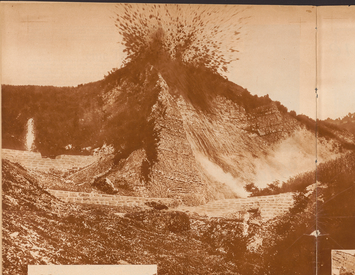
Ganze Bergkuppen werden gesprengt, um Terrain zu gewinnen. Zacken und Grate verschwinden, um humusbedecktem, beplanzbarem Boden Platz zu machen
