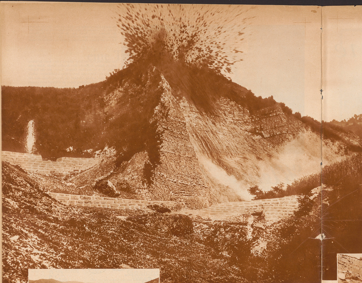
Ganze Bergkuppen werden gesprengt, um Terrain zu gewinnen. Zäcken und Grate verschwinden, um humusbedecktem, beplanzbarem Boden Platz zu machen
