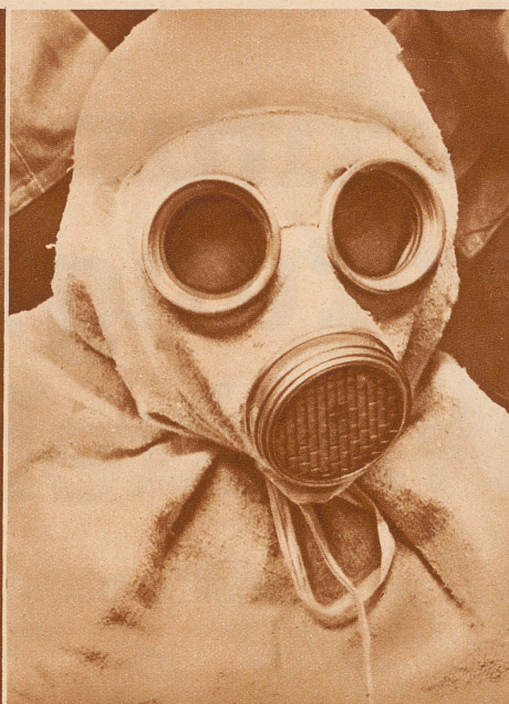
Eine Asbest-Staubmaske, die in den Fabriken zum Schutz gegen glühende Staubeilchen verwendet werden. Sie trägt den Uebernamen «Der Polarbär»
