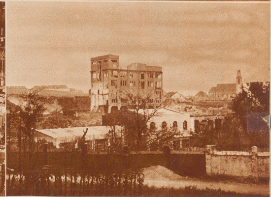
Sogar verhältnismäßig junge Bauten fallen der Krise zum Opfer. Zechenhaus bei Duisburg, das abgebrochen wird
