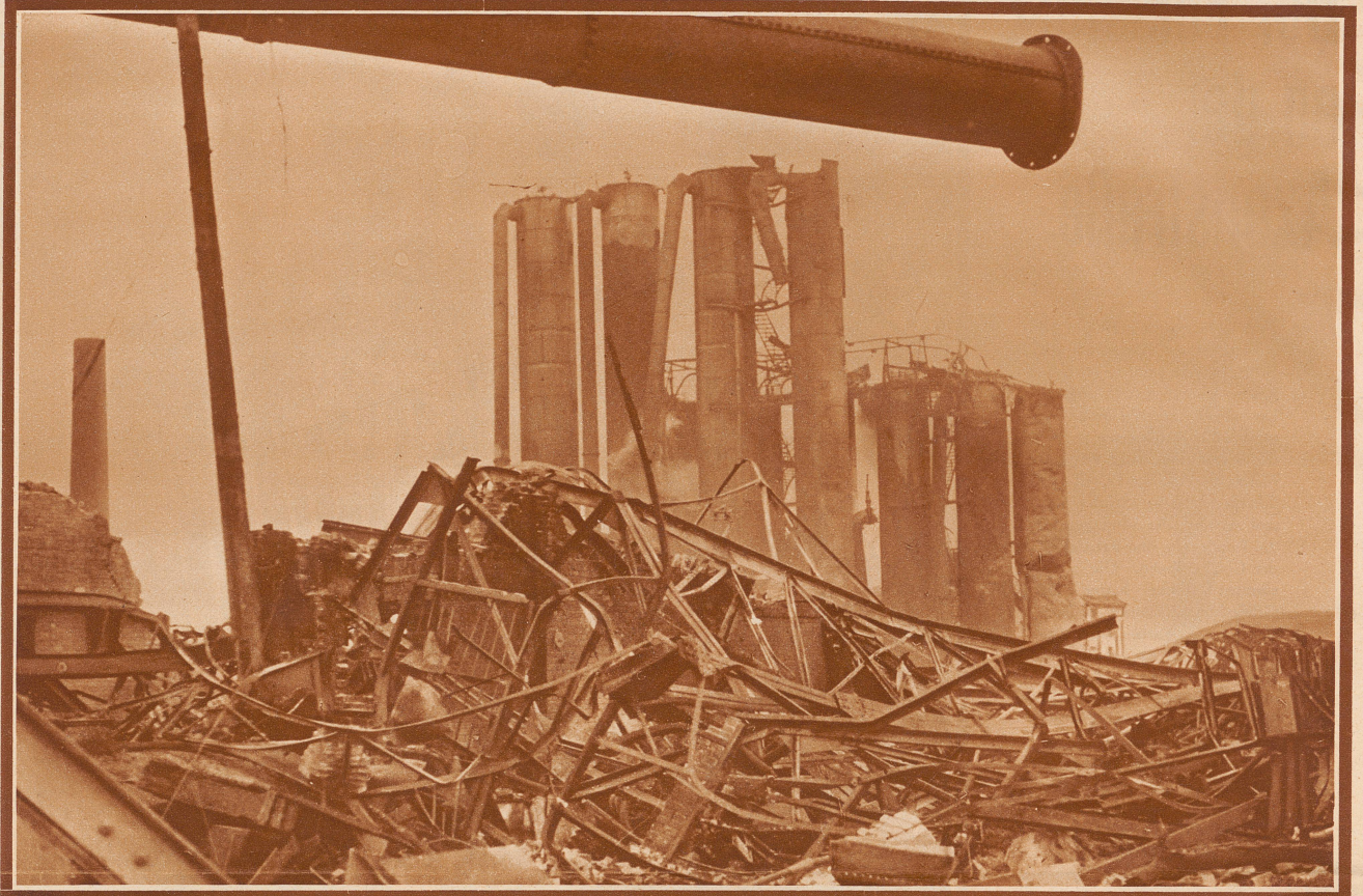
Blick über das Trümmerchaos nach der Gasometerexplosion der Neunkirchner Hütte. Im Vordergrund schwere Eisenkonstruktionen, die wie Streichhölzer geknickt wurden. Im Hintergrund die Benzolfabrik, in der ein Brand ausgebrochen ist. Der Gasometer, der hier explodierte, war der zweitgrößte Deutschlands, er war 78 Meter hoch und faßte 160 000 m 3 . Die Detonation wurde auf eine Distanz von 70 km Entfernung akustisch wahrgenommen. Zentnerschwere Teile des Gasometers wurden 3 km weit fortgeschleudert. Das Werk beschäftigte 4500 Arbeiter. Auf der Koksanlage unmittelbar neben dem Gasometer arbeitete im Augenblick des Unglücks eine Belegschaft von 70 Mann, von ihnen sind 40 umgekommen. Im ganzen forderte die Explosion über 60 Todesopfer und 190 Schwerverletzte
