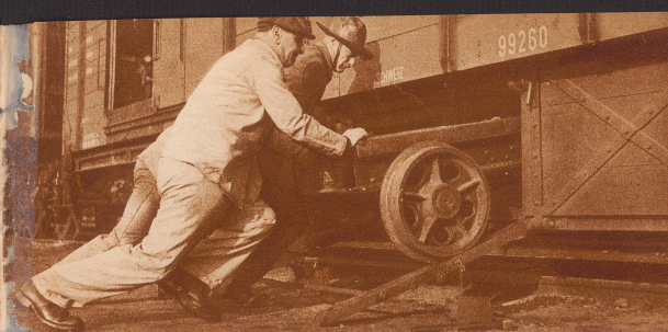
Im Fahrgestell des Hilfswagens wird ein kompletter Kollwagen mitgeteilt, der auf unklappbaren Schienen herausgenommen werden kann
