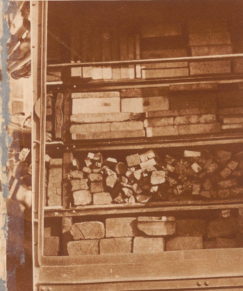
Im zweiten Geräteabteil des Hilfswagens werden schwere eichene Bretter und Bohlen mitgeführt, da es in der Regel notwendig ist, auf dem mehr oder weniger elastischen und geschotterten Bahnkörper eine feste Unterlage zu erstellen
