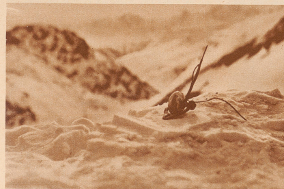
Die zerrissene Telefonleitung. Diese Leitung, die eine Spannweite von über 1000 Meter aufweist und im tiefsten Punkt 150 Meter über dem Boden hängt, wurde dem Piloten zum Verhängnis Aufnahme Casper
