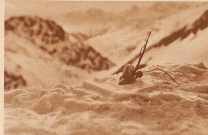
Die zerrissene Telefonleitung. Diese Leitung, die eine Spannweite von über 1000 Meter aufweist und im tiefsten Punkt 150 Meter über dem Boden hängt, wurde dem Piloten zum Verhängnis Aufnahme Casper
