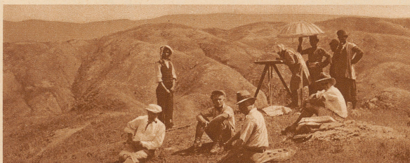
Die Schätzesucher bei der Vermessungsarbeit. Die Entfernung zwischen dem Explosionsherd und dem Seismographenstandort wird vermessen. Aus dieser Entfernung kann dann nach erfolgter Explosion die Geschwindigkeit, mit welcher die Erschütterungswellen den Untergrund durchlaufen haben und damit die Zusammensetzung des Untergrundes errechnet werden
