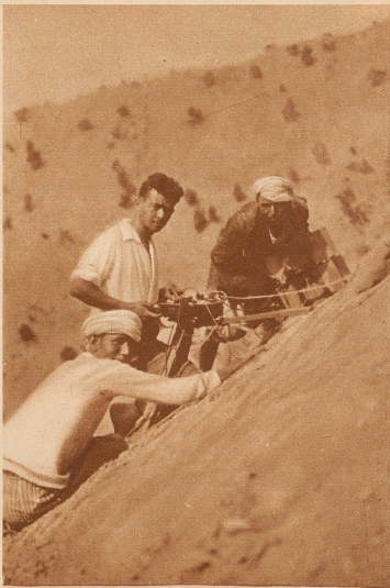
Durch eine Bodenerhebung geschützte Eingeborene bringen mittels Fernzündung die Dynamitmassen zur Entladung
