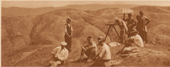
Die Schätzesucher bei der Vermessungsarbeit. Die Entfernung zwischen dem Explosionsherd und dem Seismographenstandort wird vermessen. Aus dieser Entfernung kann dann nach erfolgter Explosion die Geschwindigkeit, mit welcher die Erschütterungswellen den Untergrund durchlaufen haben und damit die Zusammensetzung des Untergrundes errechnet werden
