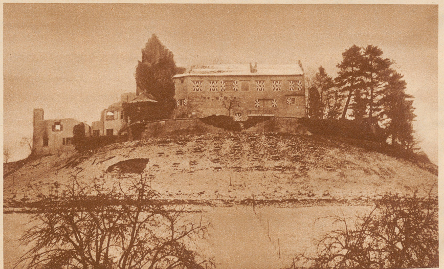
Feuer im Schloß Schwandegg. In der Nacht vom Freitag zum Samstag brach im Schloß Schwandegg bei Waltalingen ein Brand aus, dem ein großer Teil des schönen Schlosses zum Opfer fiel. Der Nordflügel des Schlosses (links im Bild) ist gänzlich zerstört. Das Schloß verfügt über eine eigene Wasserversorgung, aber es scheint, daß das Reservoir eingefroren- und so zur Bewältigung des Brandes unnützlich war. Schloß Schwandegg ist Ende des 13. Jahrhunderts erbaut worden. Augenblicklich ist es im Besitz der «Wohnbaugenossenschaft Waltaline» mit Sitz in Zürich und ständig bewohnt. Das ganze Anwesen ist für 165 000 Fr. brandversichert
