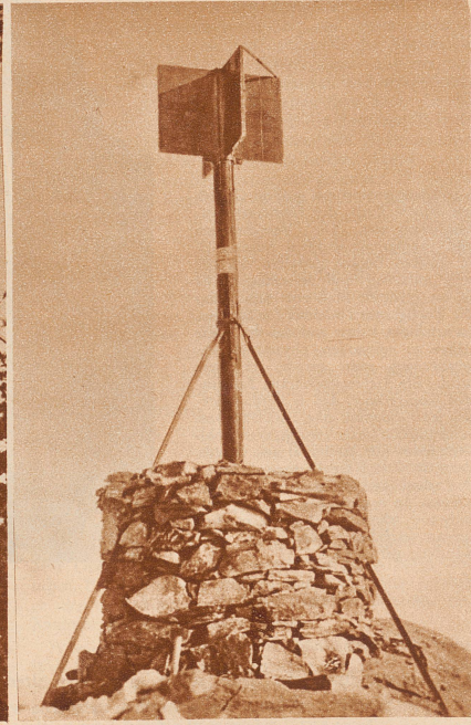
Das höchste trigonometrische Signal in der Schweiz. Der Steinmann mit dem Richtungskreuz auf der Dufourspitze, dem höchsten Punkt im Monte-Rosa-Massiv. Es steht 4638 Meter über Meer. Ingenieur Bühler benötigte mit drei Gehilfen fünf Tage angestrengter Arbeit für die Errichtung dieses Signals
