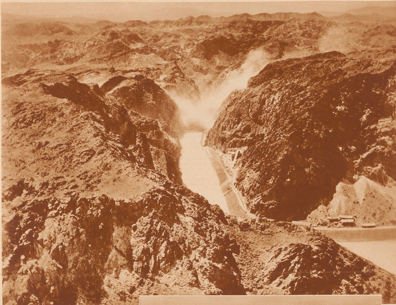
Die menschenleere, vegetationslose, ausgetrocknete Landschaft an der Grenze der Staaten Arizona, Nevada und Kalifornien mit dem steilen, über 200 Meter tiefen Einschnitt des Colorado-Stromes, wo der Hooverdamm errichtet wird
