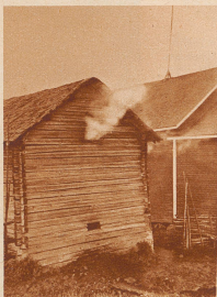
Das Badehäuschen. Es hat keinen Schornstein; der Rauch entweicht durch eine Luftklappe oben am Haus
