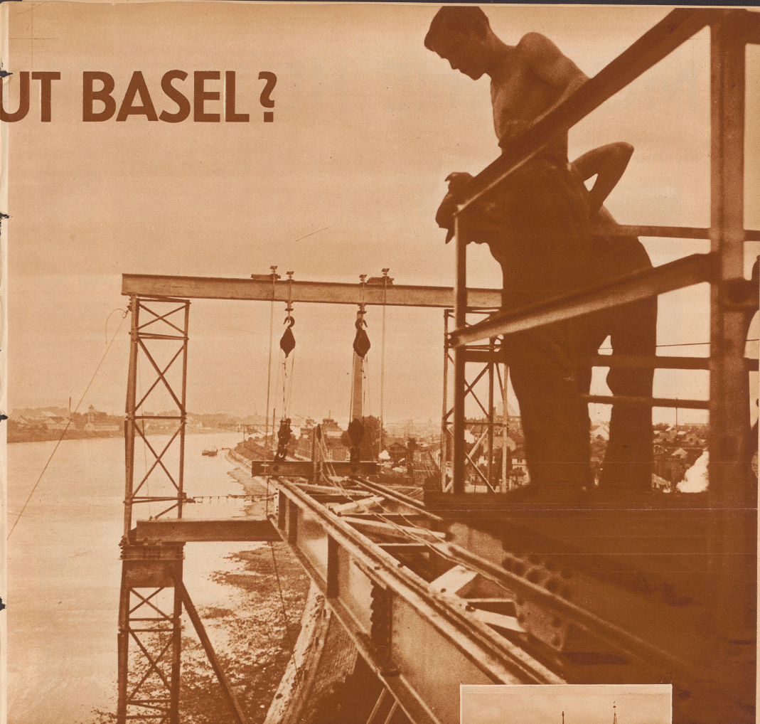
Die Dreirosenbrücke im Bau. Als fünfte Basler Brücke wird sie bis übers Jahr mit zwei Pfeilern im Wasser den 200 Meter breiten Rhein überspannen und Groß- und Kleinbasel noch inniger als bisher miteinander verbinden
