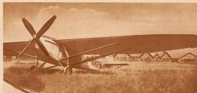
Das Farmansche Stratosphärenflugzeug. Von außen gesehen ein ganz gewöhnlicher Eindecker, nur der vierflügelige Propeller, die stabilere Bauart und das Fehlen von Türen und Fenstern unterscheidet die Maschine von dem gewöhnlichen Typ
