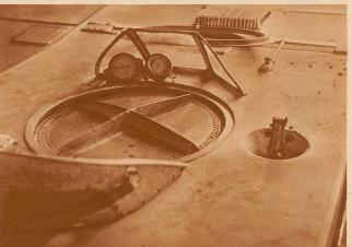
.... die nun hermetisch verschlossen wird. Die Luftzufuhr erfolgt durch einen Kompressor, der auch in 20 000 Meter Höhe den Druck auf gleicher Höhe hält wie auf 3000 Meter. Es wird von jetzt ab vollständig blind geflogen.
