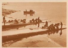
Das ist die Gleitbahn aus Eichenholz, auf der die «Normandie» ins Meer rutschte. Mit einer Geschwindigkeit von 5,5 m in der Sekunde gleitet der Riesenkörper, durch das lügengewicht in Bewegung gestert, im Waser. Damit so ein Stapellad ohne Zwischenfälle ors fängeheit, müsen die Gleischienen ganz gehörig eingefettet werden. Hier wurden 46 600 kg Talg und Seife zum Preise von 15000 Franken zu dem Zwecke verbrauch
