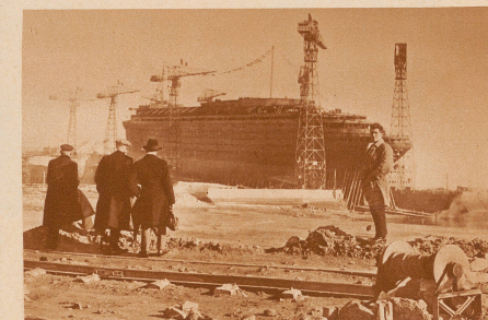
Die «Normandie» noch in der Werft, umgeben von den Riesenkranen, unmittelbar vor dem Stapellauf. Ein Heer von Ingenieuren und Arbeitern war 14 Tage damit beschäftigt, den nicht ungefährlichen Stapellauf dieses enormen Last vorzubereiten. Zu dem Gerüst, das für den Stapellauf gebaut werden mußte, wurden 2200 Kubikmeter Holz verwendet.
