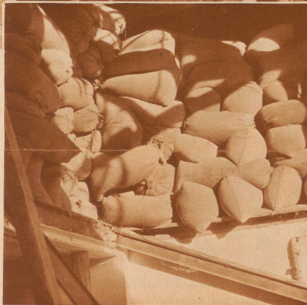
100 000 kg Mais und Gerste, 10 Eisenbahnwagen voll, lagerten auf dem Dachboden. Die Eisenträger der Decke bogen sich unter der Last, verloren den Halt auf den Stützmauern und – das Unglück war geschehen
