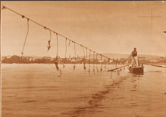
Die Suchleine wird verankert, dann von zwei Booten mittels eines Tauses über den Seegrund gezogen. Von Zeit zu Zeit wird sie heraufgeholt, um die Angeln von dem aufgespießten Moos, etc. zu befreien
