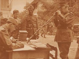
Der Herr Waffenkontrolleur auf der Suche nach Wasser- und Rostflecken im Gewehrlauf. Alle Waffenbestandteile müssen entfettet zur Inspektion vorgewiesen werden
