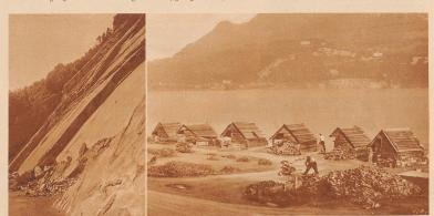
Schicht um Schicht wird aus dem über 50 Meter hohen Steinbruch abgesprengt. Die kleinen Menschen und das Wägelein am Fuße des Felsen geben den Maßstab für die Ausdehnung der Abbruchstelle
