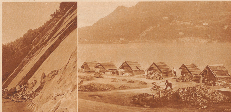
Schicht um Schicht wird aus dem über 50 Meter hohen Steinbruch abgesprengt. Die kleinen Menschen und das Wägelchen am Fuße des Felsen geben den Maßstab für die Ausdehnung der Abbruchstelle
