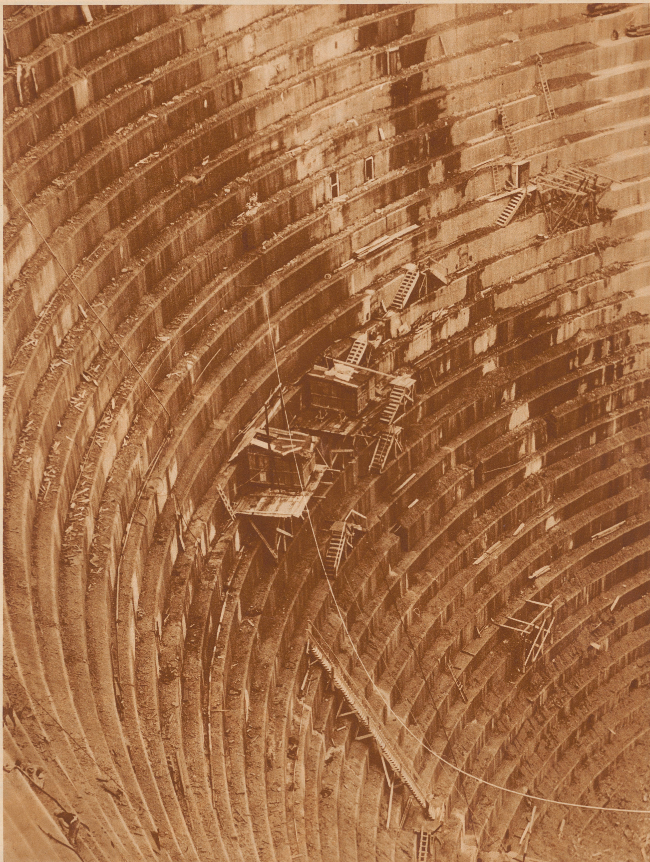
Das ist ein Ausschnitt aus der großen Spitalamm-Sperrmauer des Grimselwerkes, zur Zeit, da die Mauer fertiggestellt war und vom Bauschutt gereinigt wurde. Die Mauer ist 114 Meter hoch, an der Basis 65, an der Krone 4 Meter breit. Die zahlreichen Abstufungen sind gemacht, damit eine eventuelle spätere Steinverkleidung möglich wird. Die Absätze sind 2 Meter hoch und 1 Meter breit. Die kleinen Hütten, die wie Schwalbennester an der Wand kleben, sind Baubaracken. Sie vermitteln einen guten Maßstab der Riesenausmaße des Bauwerkes. Die sichtbaren Oeffnungen in der Mauer werden zum Teil zum Messen der Mauertemperatur benutzt, zum Teil sind es Fugen, die zur Konstruktion nötig waren
