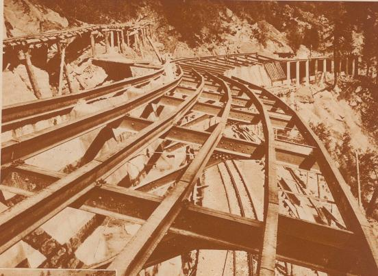
Eisenkonstruktion eines Galeriedaches
