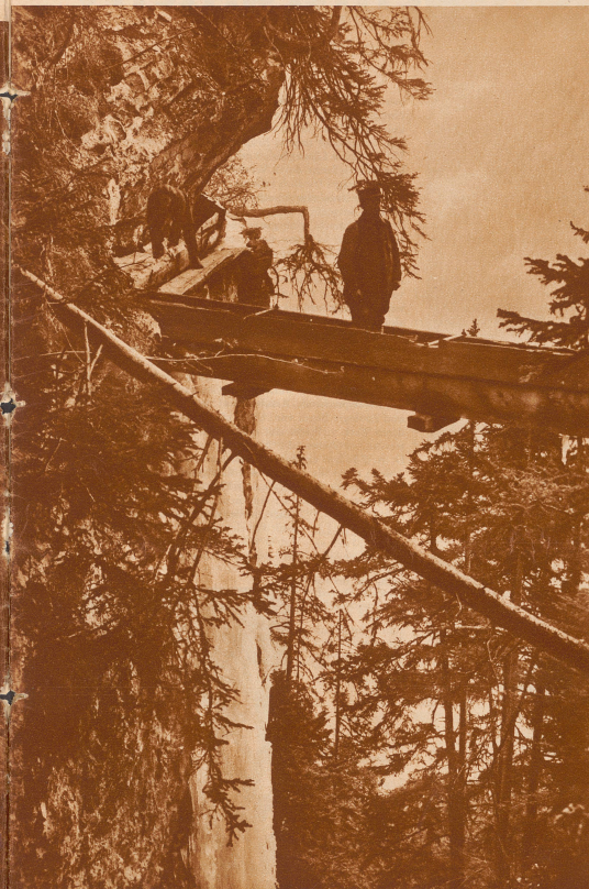
Hier ist noch ein Stück jener echten alten Holzkanäle zu sehen, die sich um schwindlige Felswände herum und steile Hänge entlang ziehen. Diese unter Lebensgefahr erstellten Leitungen zeugen für die zähe Ausdauer, womit der Walliser Bauer sich von der Natur das unentbehrliche Wasser abtrözt. Aufnahme: Ch. Dubon.
