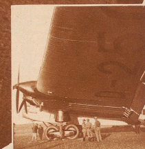
Alles an dieser Junkersmaschine «G 38» ist riesenhaft. Ihre Spannweite beträgt 44 Meter, die Spurweite der mannshohen Riesenräder mehr als 8 Meter. Es faßt 40 Passagiere und eine Besatzung von 6 Mann. Die Motoren sind in die Flügel eingebaut
